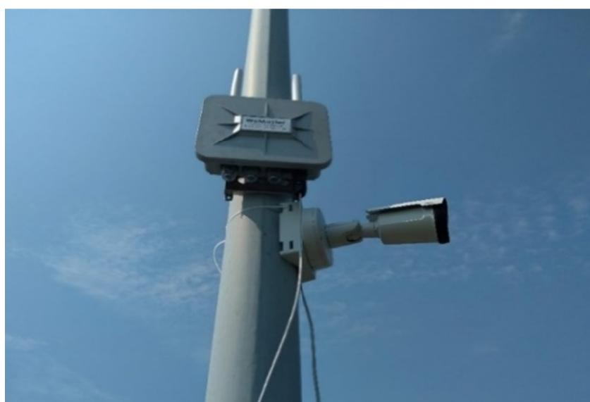
圖 3-5 相關設備測試時暫時固定於燈桿
