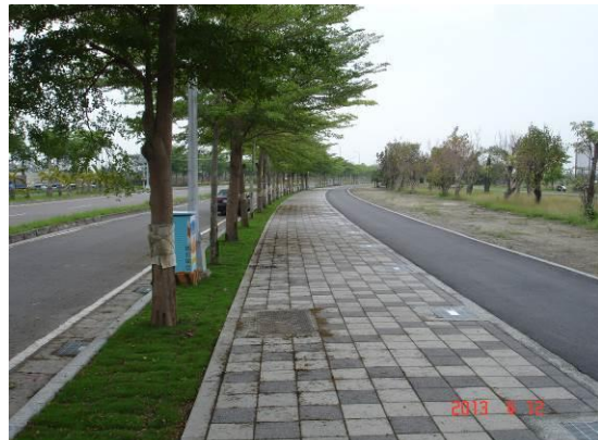
(d) 路面竣工
