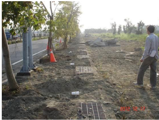
(c) 鋪設焚化底渣再生粒料
