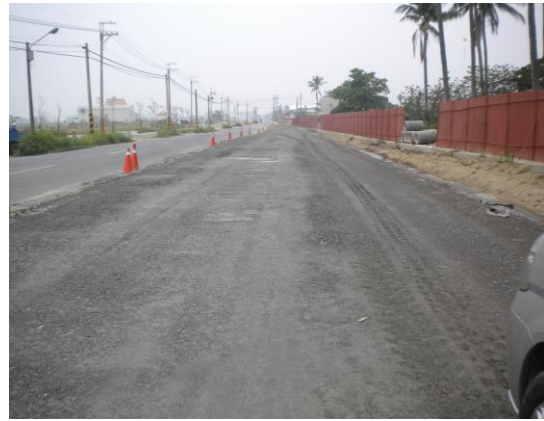
(b) 道路底層鋪設完成
