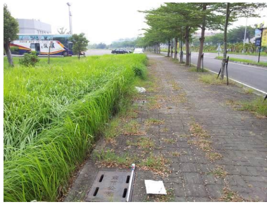
(a) 施工前路面
