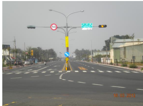
(d) 0K+958~1K+500 路面竣工
