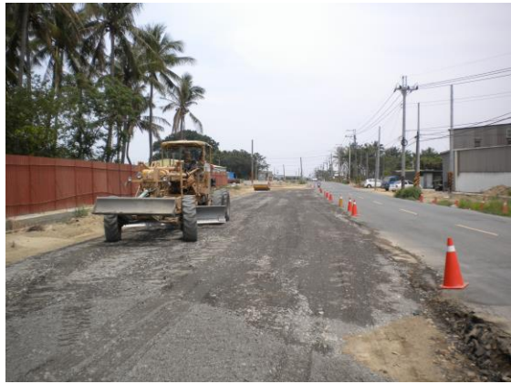
(a) 焚化底渣再生粒料級配推平壓實
