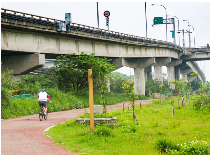
溪埔子人工濕地工程成為打造頭前溪左岸運動休閒綠色廊帶的重要起點／柯霽婕攝
