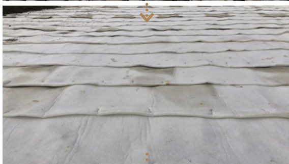
槽體上方鋪設透水不織布
