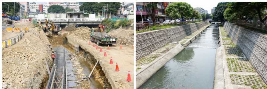
左 · 埋設污水截流溝並連接污水下水道系統（施工中）／臺中市政府水利局提供 右 · 柳川整治後乾淨的河道（施工後）／莊亦吏攝
