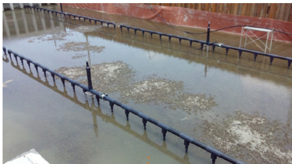
曝氣系統埋設後加水測試曝氣管水平程度
