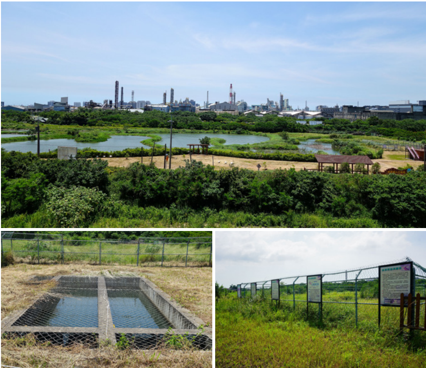
上・由高處俯視東興橋人工濕地／莊亦吏攝 左・污水截流後先進入沉砂池沉澱處理／莊亦吏攝 右・沉砂池等以圍籬隔開，避免民眾誤入，但在圍籬上設有大型解說牌，落實環境生態教育／柯霽婕攝
