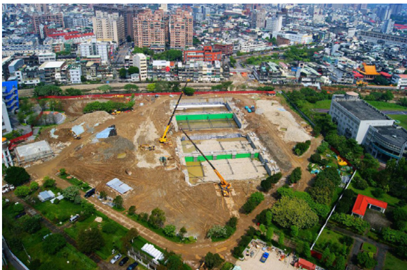
礫間設施施工中／桃園市政府環保局提供
