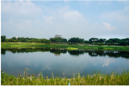
左 · 虎高污水處理場放流池／鍾昆展攝
