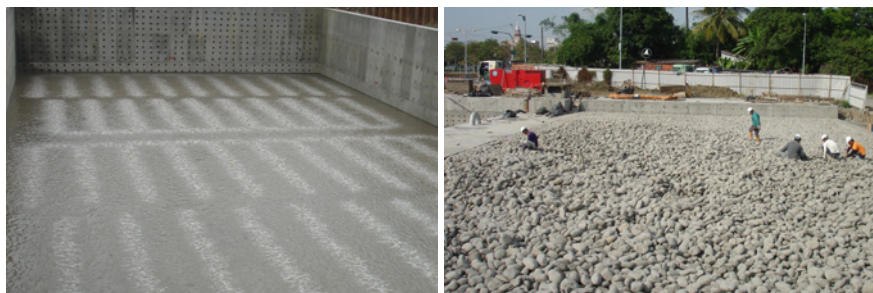
左・礫間淨化場曝氣管線曝氣測試／高雄市政府水利局提供
