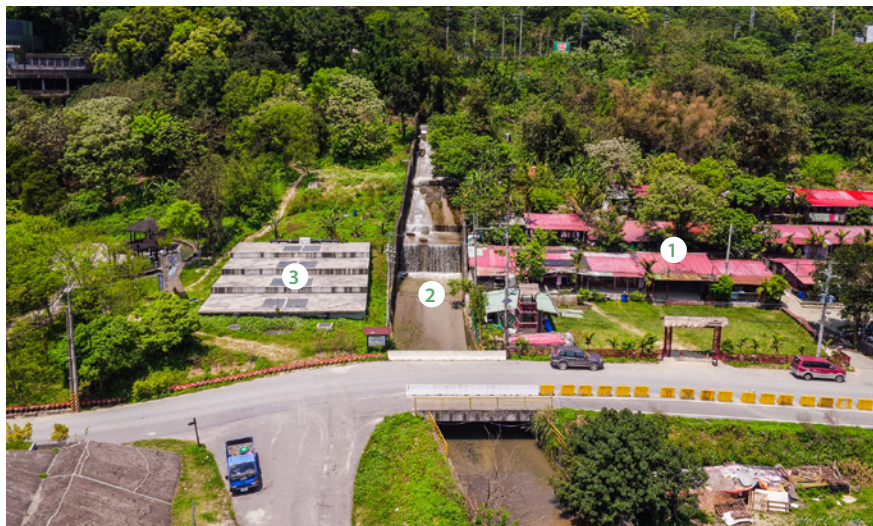
埔頂大排水前端處理：1・撒烏瓦知原住民部落 2・埔頂大排 3・大排旁邊的沉澱池／韋旭科技攝
