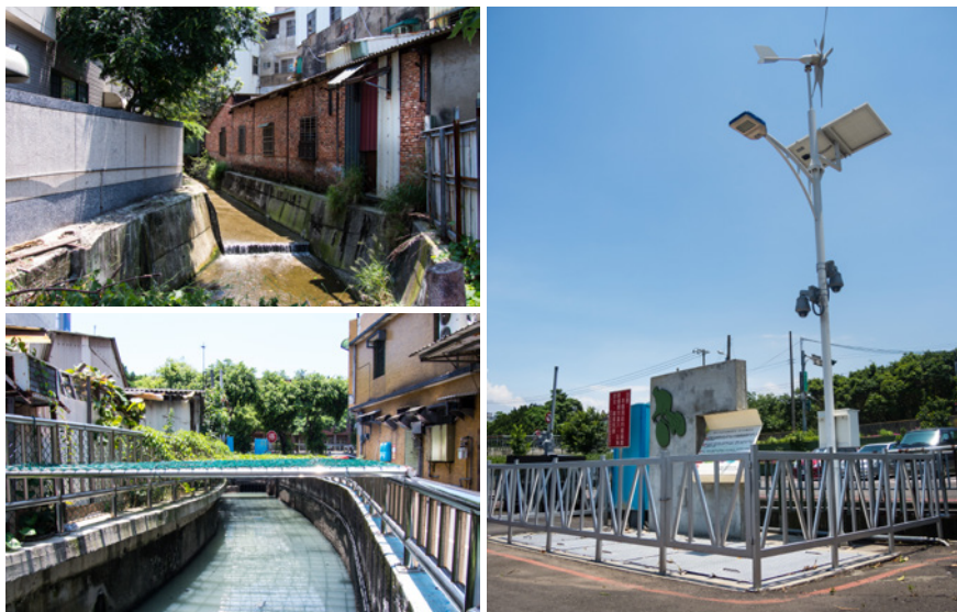
上・警光一村區域排水／呂慧穎攝 下・西大路竹樂食堂截流站／呂慧穎攝 右・截流站電子偵測系統以太陽能及風力供電／呂慧穎攝
