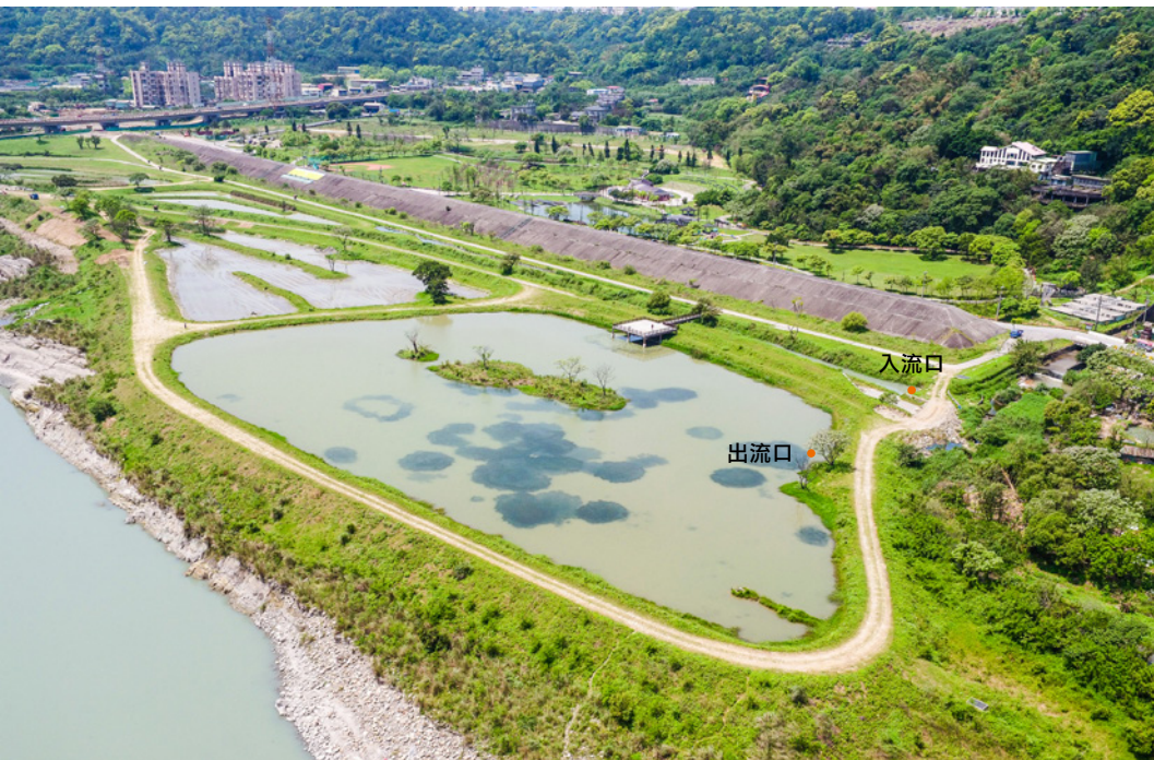
埔頂大排截水跟出流口安排在同一側的設計，讓土方工程就地平衡／韋旭科技攝
