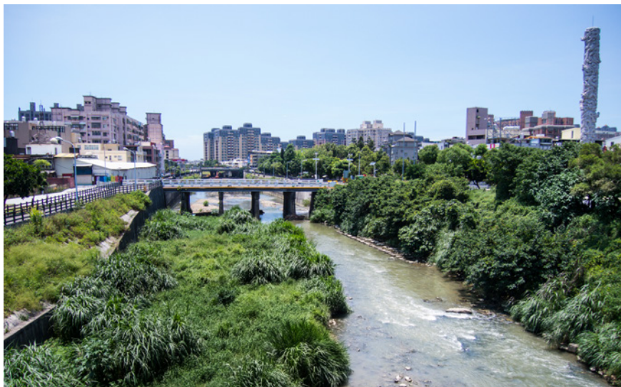
上游事業廢水管制及沿岸民生污水截流，逐步改善客雅溪水質／呂慧穎攝
