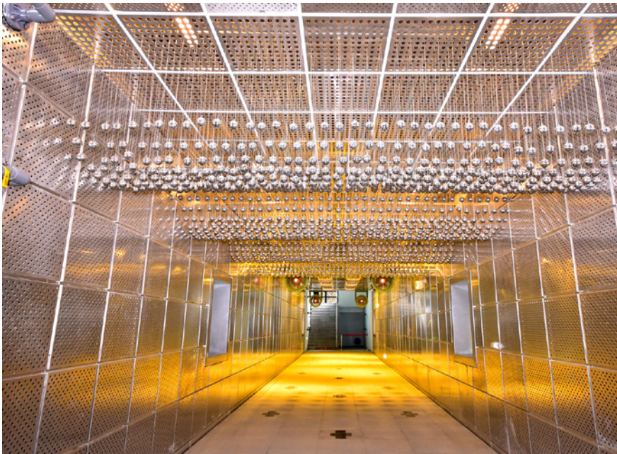
上 · 中華水質淨化場礫間淨化槽（施工中）／臺中市政府水利局提供
