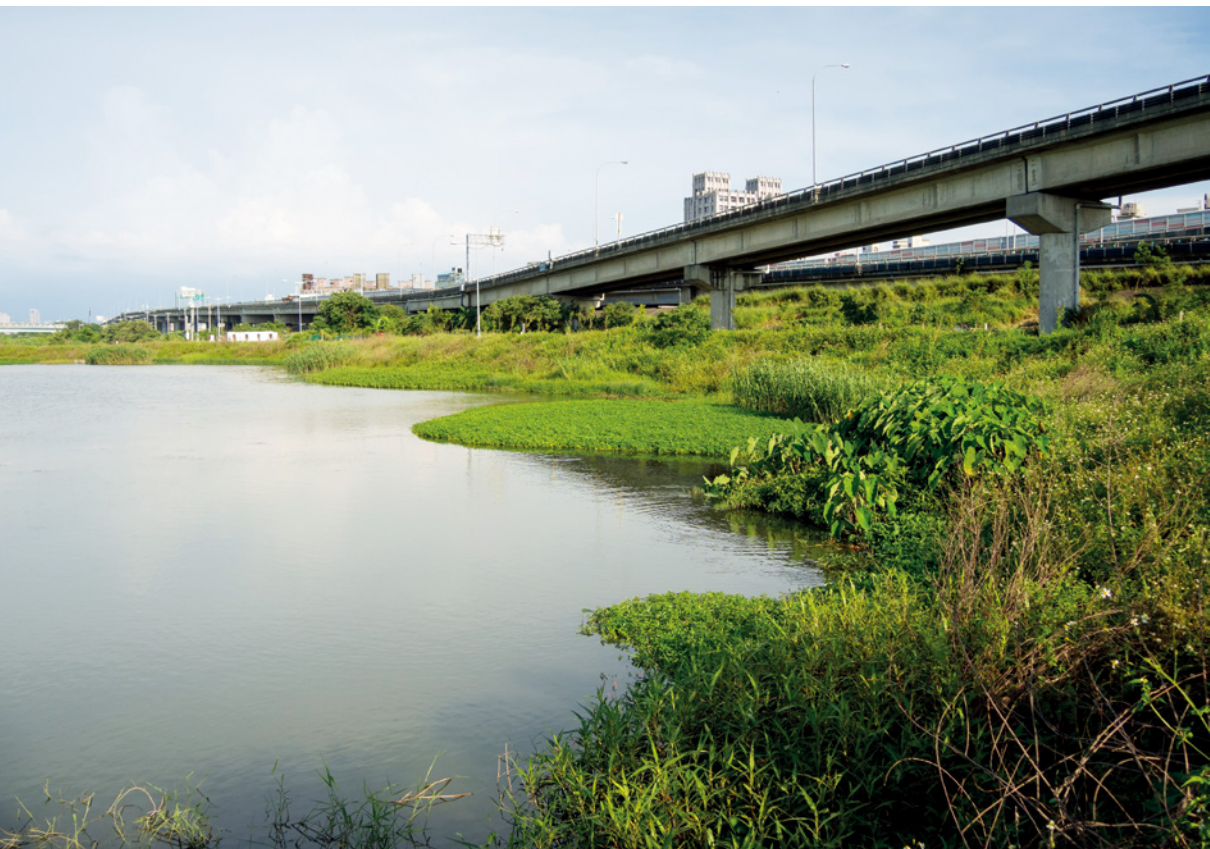
河岸整治、人工濕地完工後，河岸環境也變得親切了／呂慧穎攝
