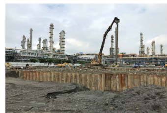
鋼板樁打設
