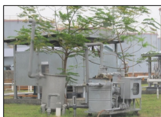
SVE/AS設備設置
