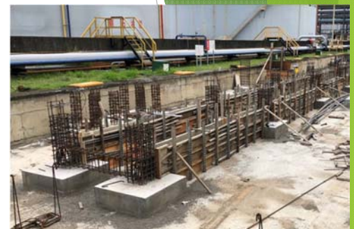
儲槽加裝油氣回收裝置 (安裝、採購中)
