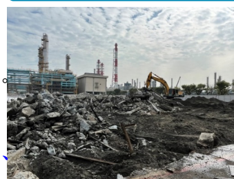
地坪拆除作業
