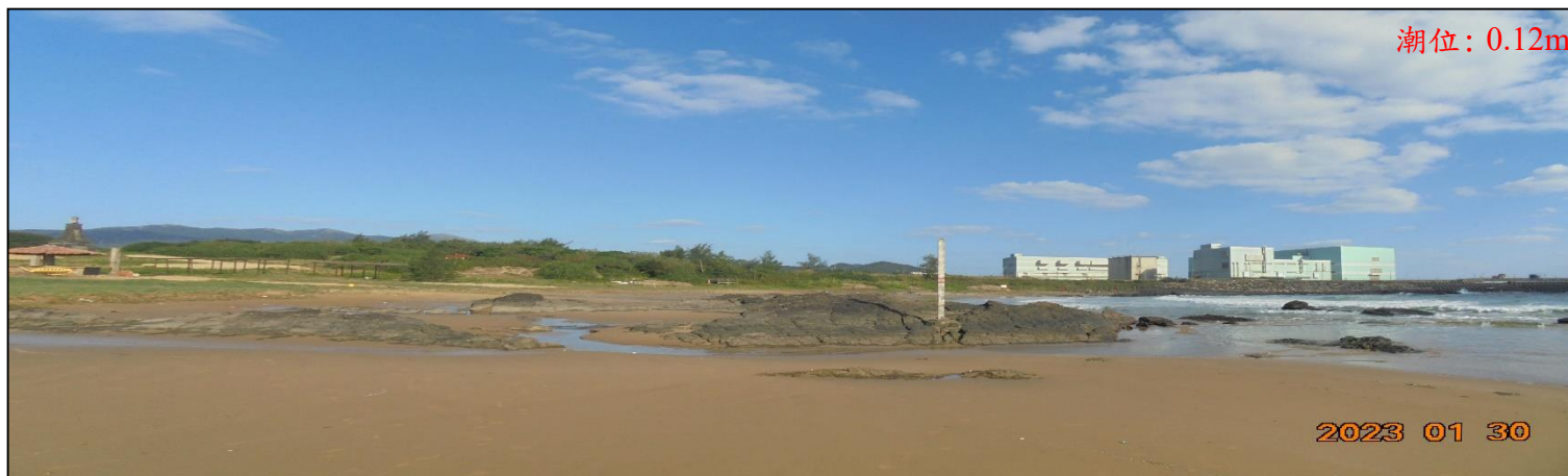
圖 4-4A 監測區北側礁石區內#S2 樁附近地形 (2023/01/30)
