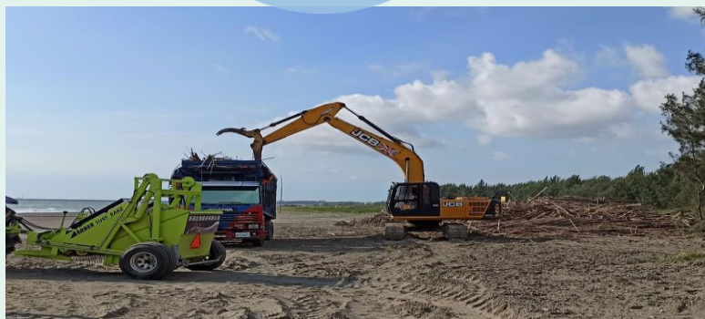
臺南黃金海岸蚵架清理作業情形
