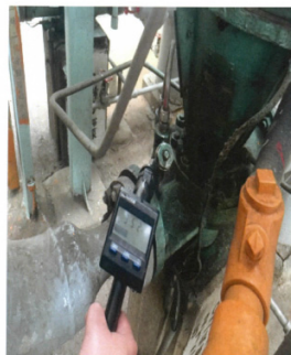
PUMP 改台，製程流體排空，Y 型濾網重 新安裝加鎖，複測值 3.52ppm
