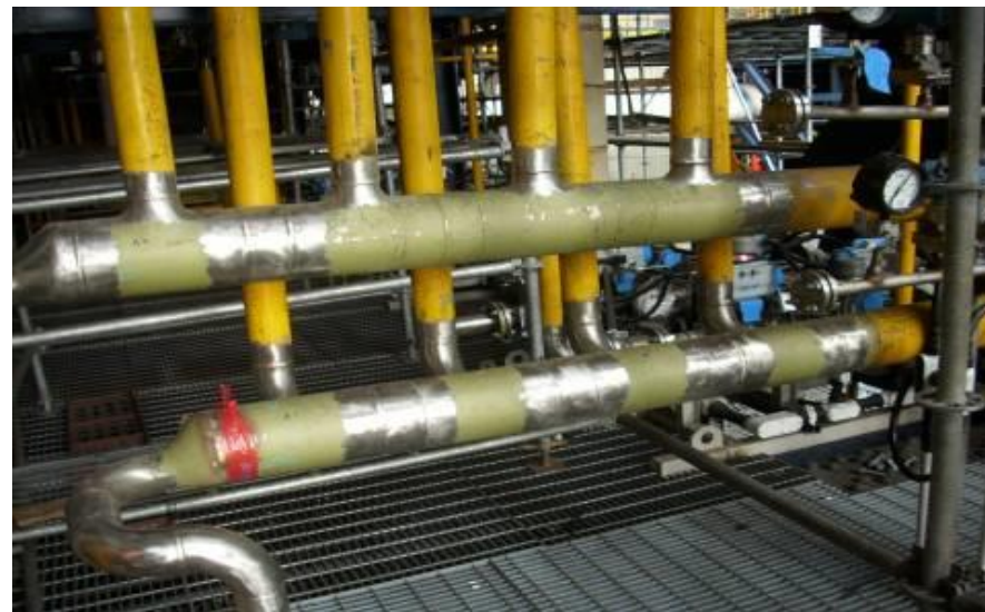
鍋爐改善(新增甲烷氣集管)
