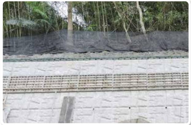
圖8-10 生態保護對象-大樹·現地明確標示(頓阿巴娜野溪上游崩塌地處理工程)及施工邊界設置黑紗網降低對動物干擾(三灣大河底野溪整治三期工程)
