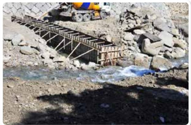
圖8-11 靜水池設置緩斜坡道避免動物受困(達德安伊亞那野溪整治三期工程)及將溪水導離工區避免水質污染(阿里不動溪二期整治工程)
