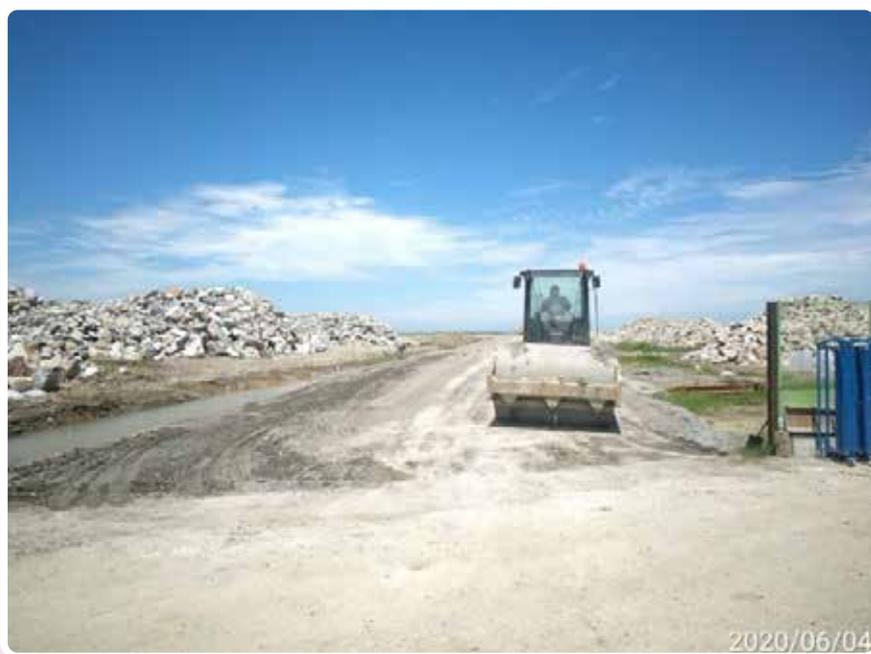
圖11-1 109年「臺北港第二期物流倉儲區第二條施工便道鋪設再生粒料試驗」完工現場
