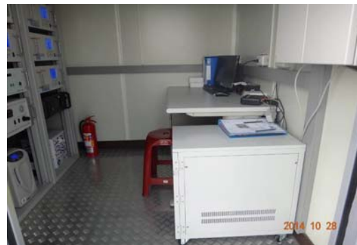
103 年 10 月 28 日 設備拆除後
