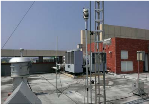
103 年 10 月 20 日 架設設備
