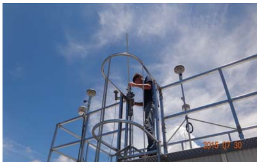
104年7月30日設備拆除工作
