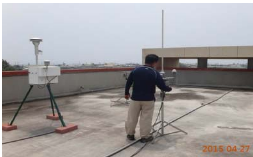
104年4月27日 設備拆除工作
