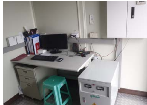
104年1月27日 設備拆除後
