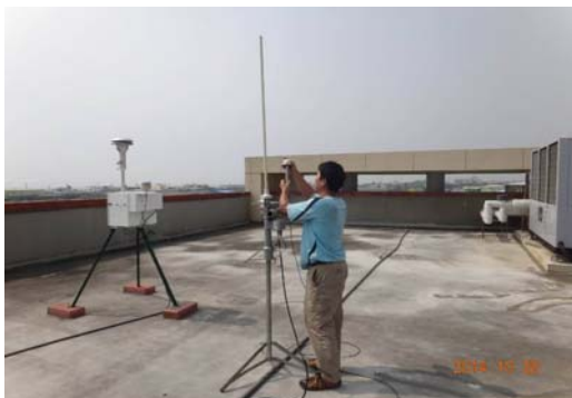
103 年 10 月 28 日 設備拆除工作
