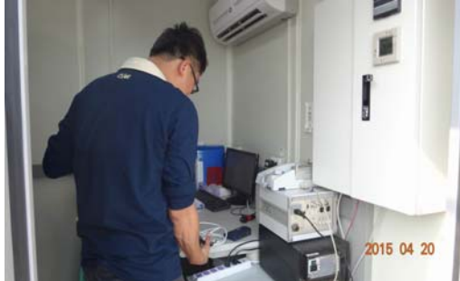
104年4月20日架設設備
