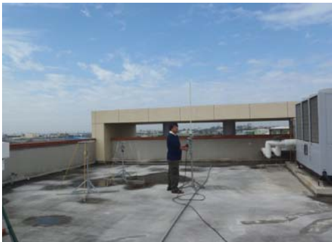
104年1月27日 設備拆除工作
