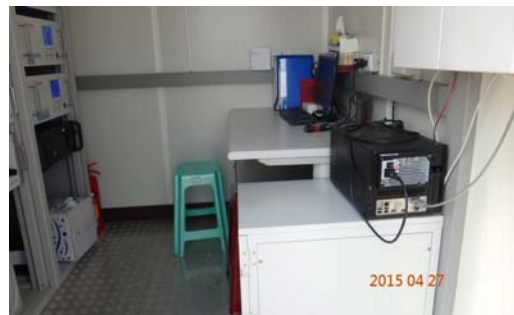
104年4月27日 設備拆除後
