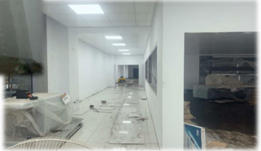
六樓辦公室裝修照片
