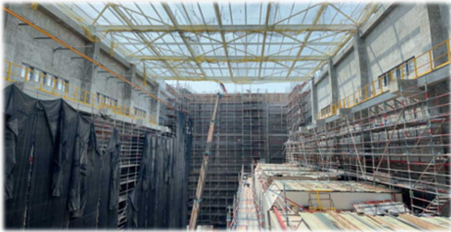
儲坑區維修走道及護欄施工照片
