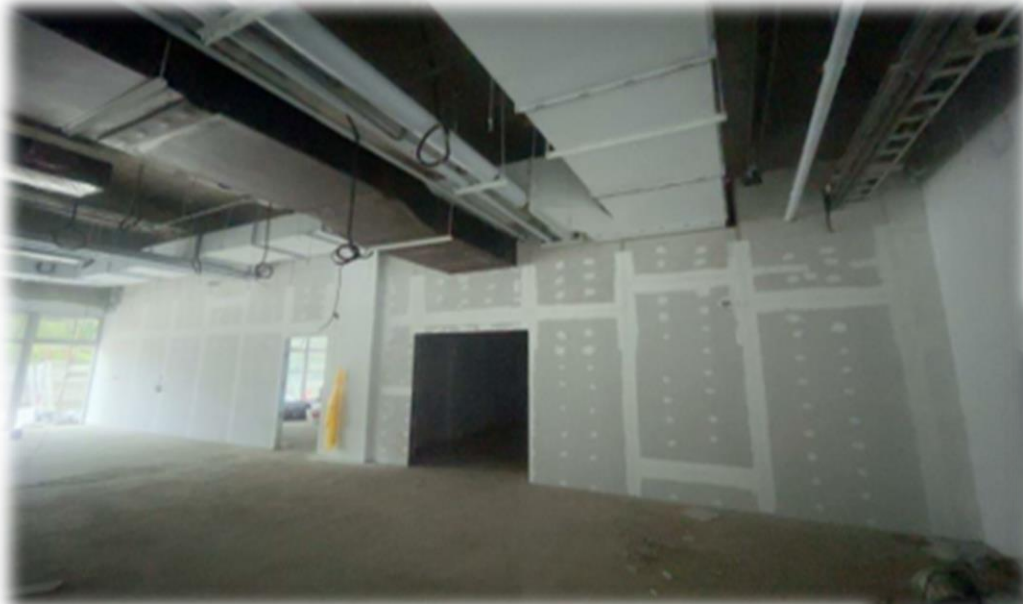
一樓辦公室裝修照片
