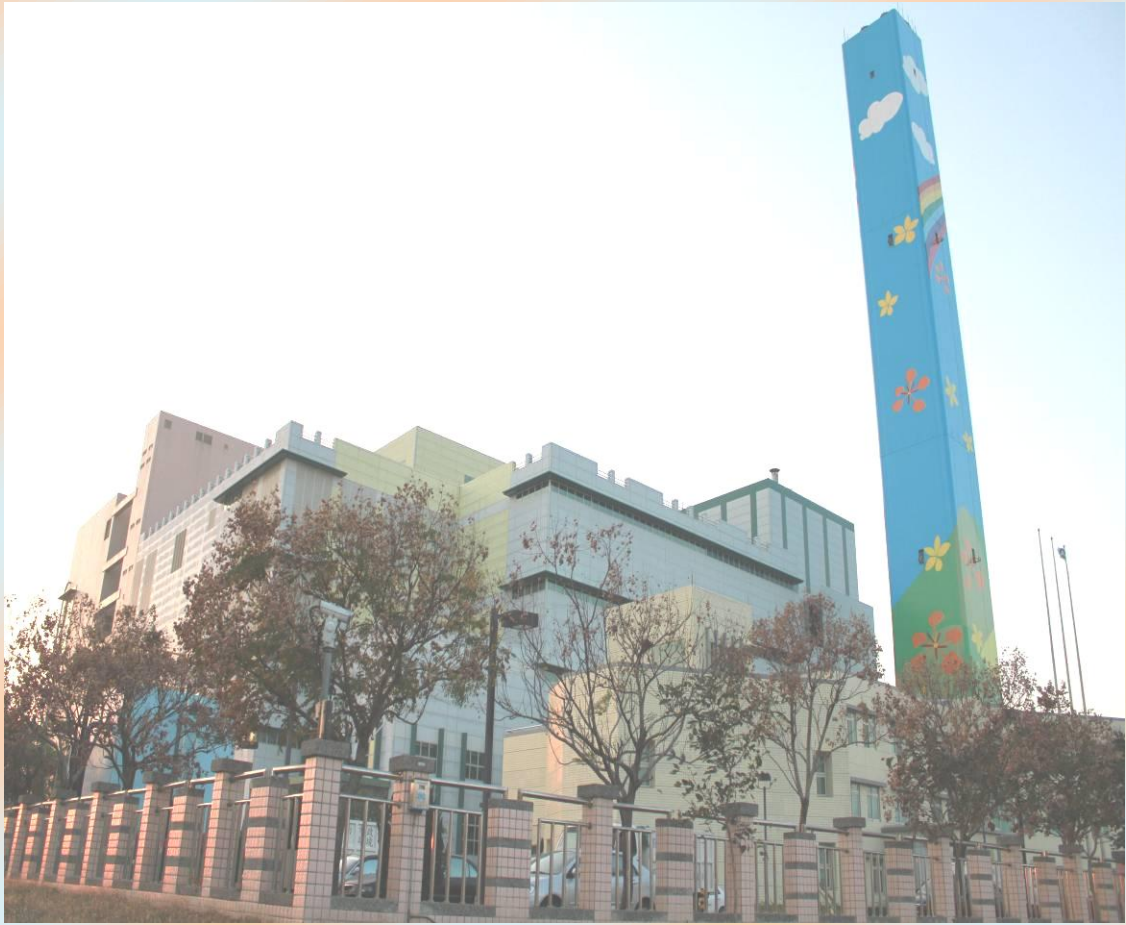
臺南市永康垃圾資源回收(焚化)廠全景圖
