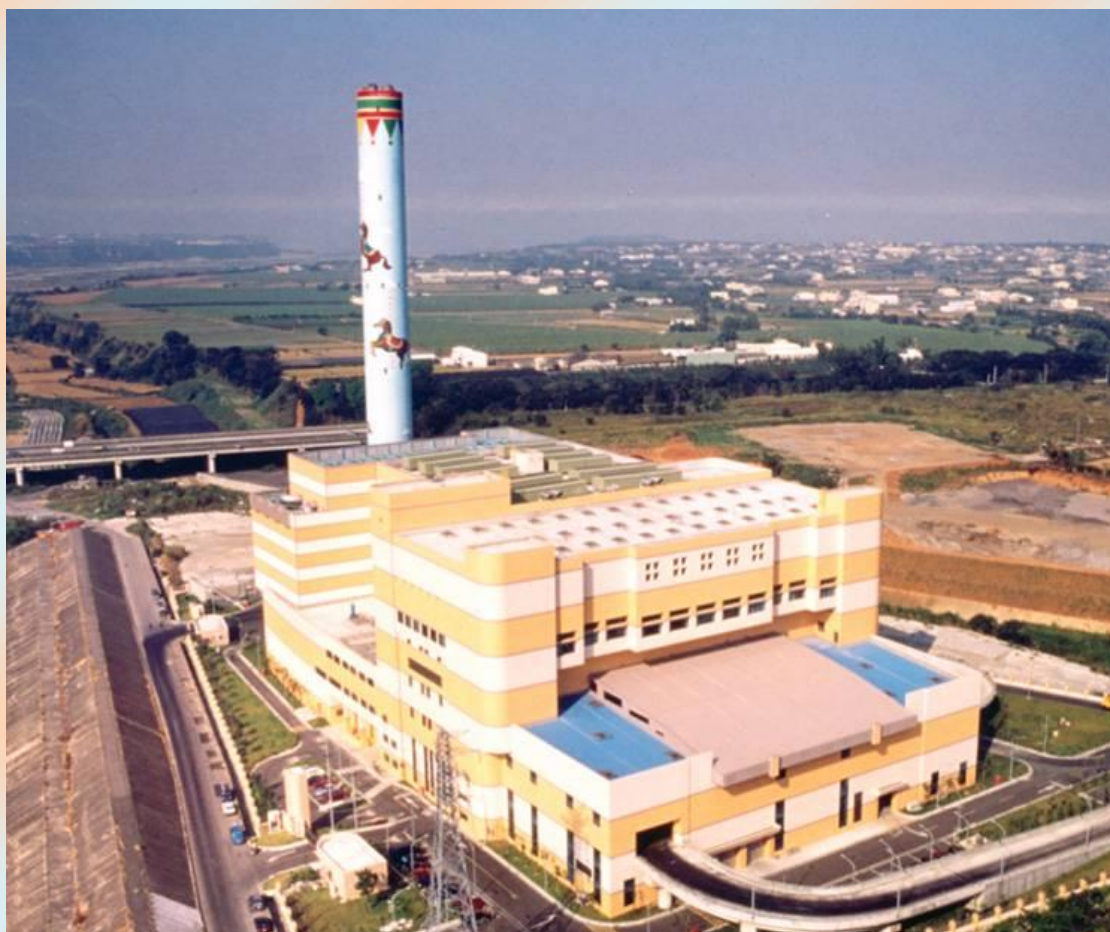
臺中市后里資源回收廠全景圖
