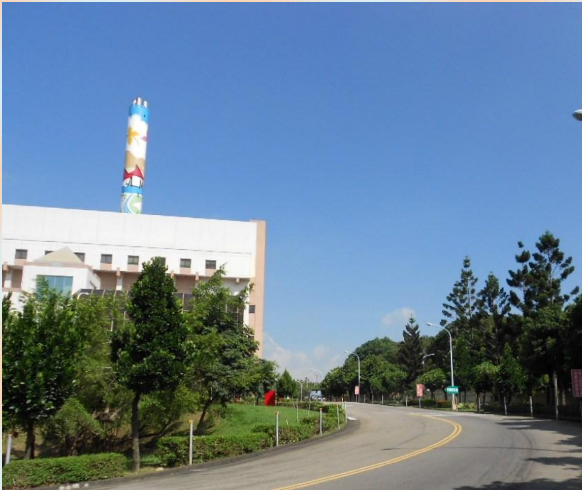
臺中市文山垃圾焚化廠全景圖
