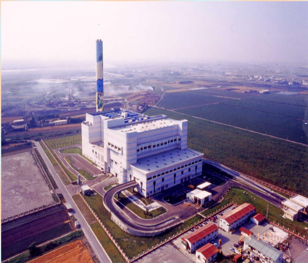
彰化縣溪州垃圾焚化廠全景圖
