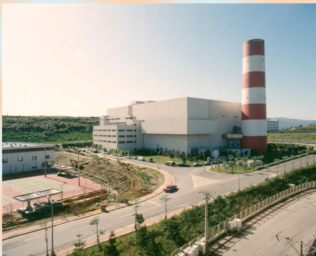
臺北市政府環境保護局內湖垃圾焚化廠全景圖
