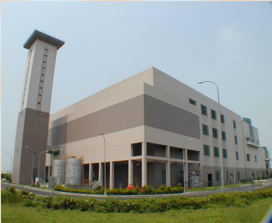
高雄市岡山垃圾資源回收(焚化)廠全景圖
