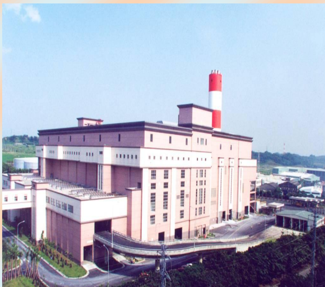
高雄市政府環境保護局南區資源回收廠全景圖
