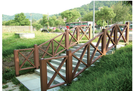
▶ 混合廢標籤細粉製成之塑木，應用於步道扶手
