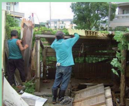
拆除工作進行中
