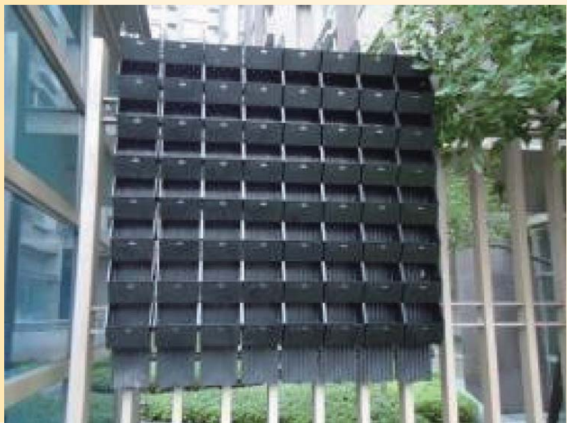
植生牆施工—安裝基礎架座
