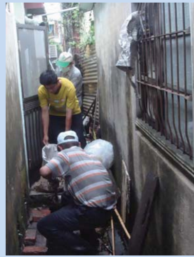
清除防火巷污水溝、髒亂點
