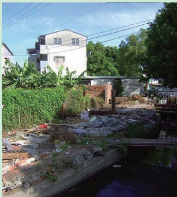
拆除工作完成
