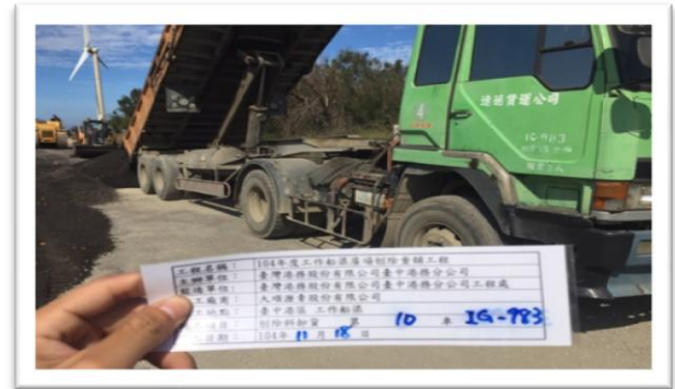
刨除料卸貨、整地處理
