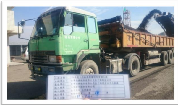
AC 路面刨除施工
