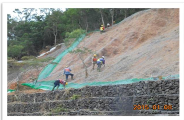
臺 9 線邊坡植生工程
