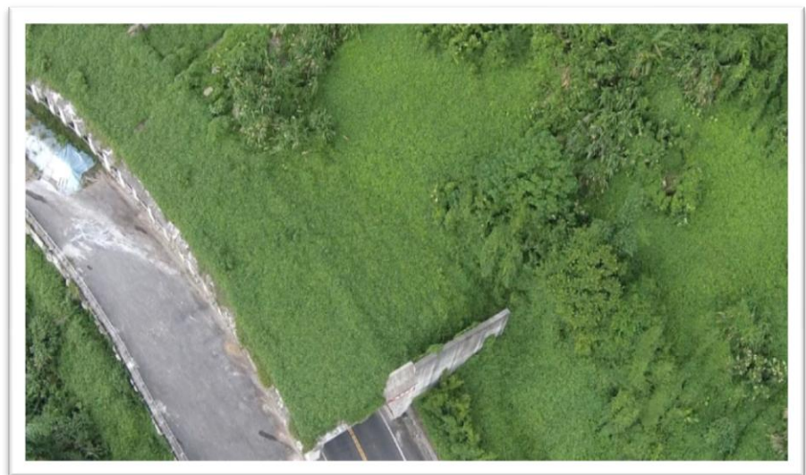
明隧道回收再利用廢輪胎當攔石壩(施工後)
