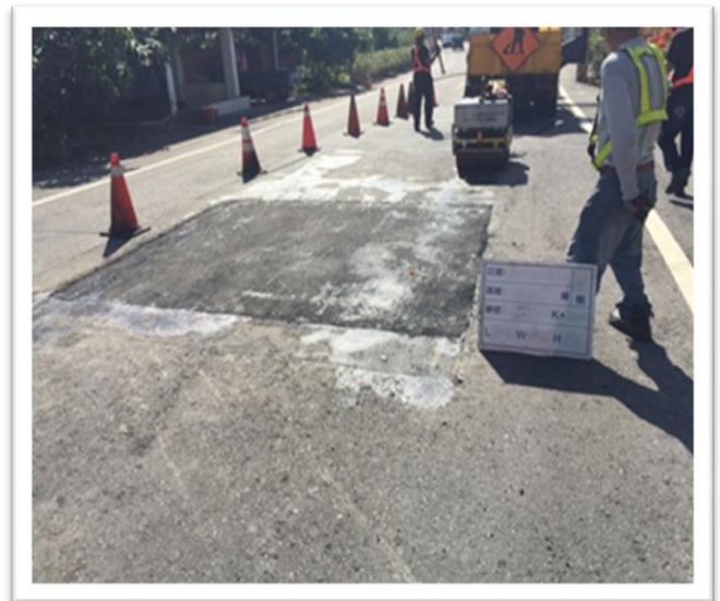
臺 27 線路面修補
