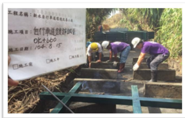
新水自行車道環境改善工程 (現有路緣石作為基底)
