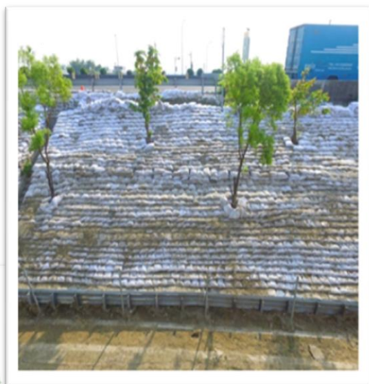
搶災固坡施完竣工 示意圖
