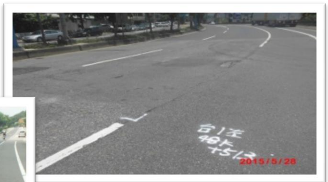
臺 1 線路面整修工程(施工前)
