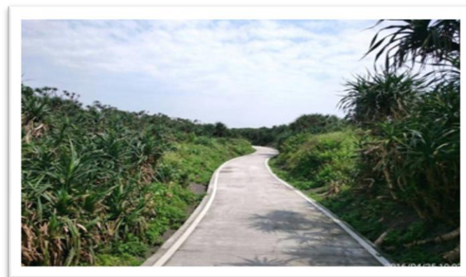
新水自行車道環境改善工程(施工後)
