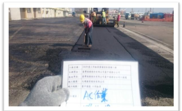
AC 路面鋪設施工
