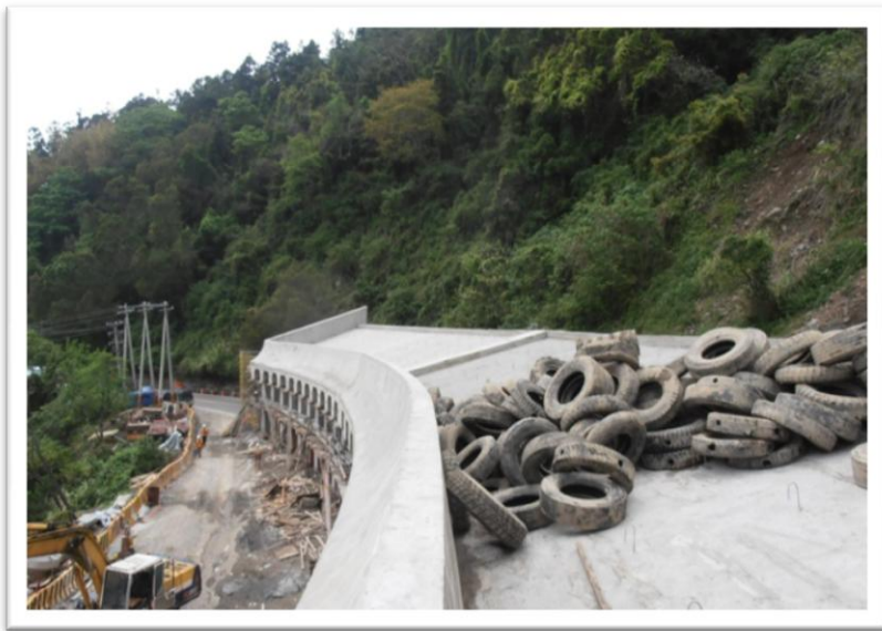
明隧道回收再利用廢輪胎當攔石壩(施工前)
