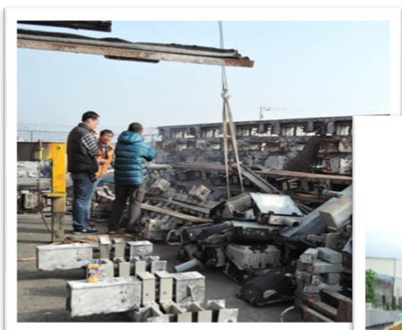
報廢模組型伸縮縫堆置
