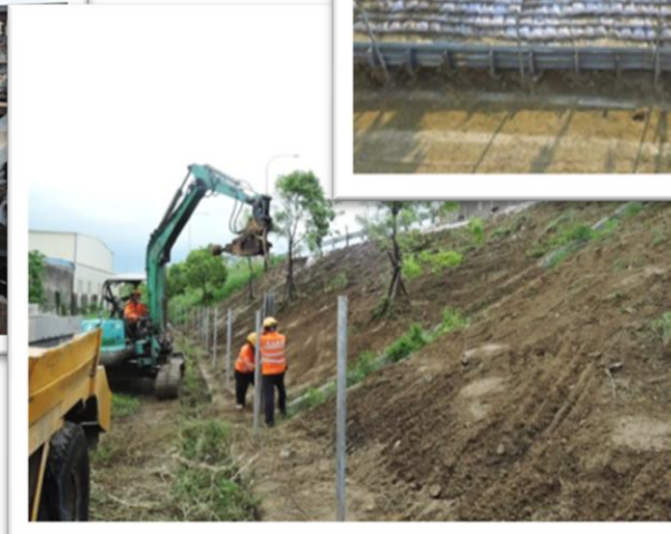
H 型鋼及護欄鋼板打入坡趾
