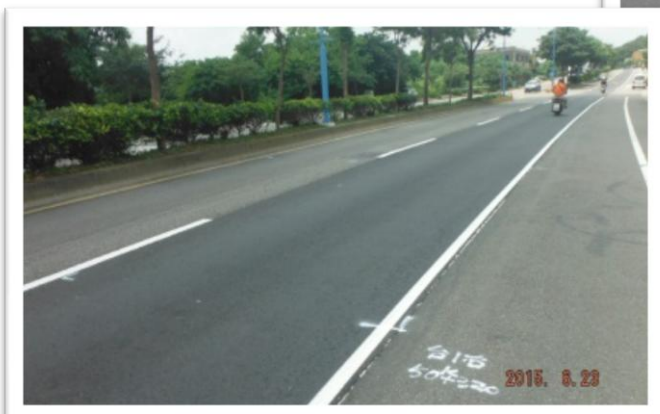
臺 1 線路面整修工程(施工後)
