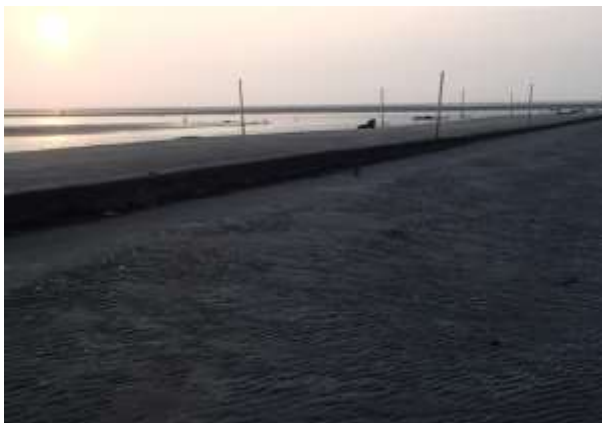
照片 1.3-24 螻蛄蝦漢寶測站
