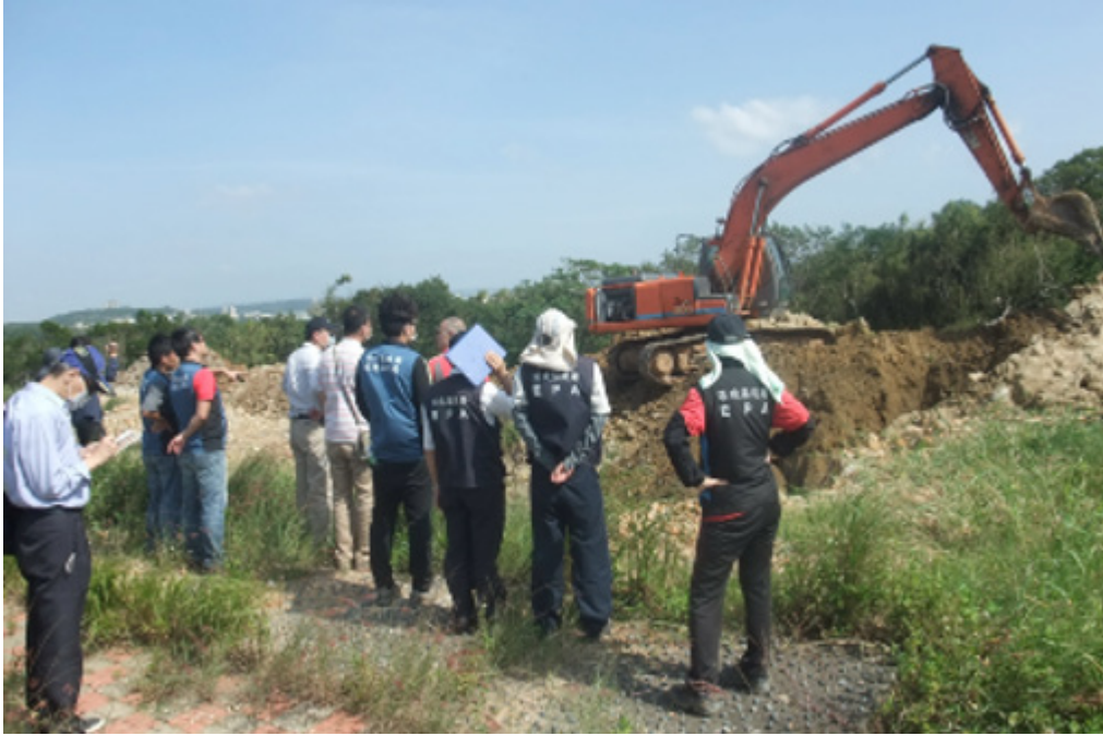
▶ 環保署會同環保局，監督挖土機開挖違法掩埋廢棄物
