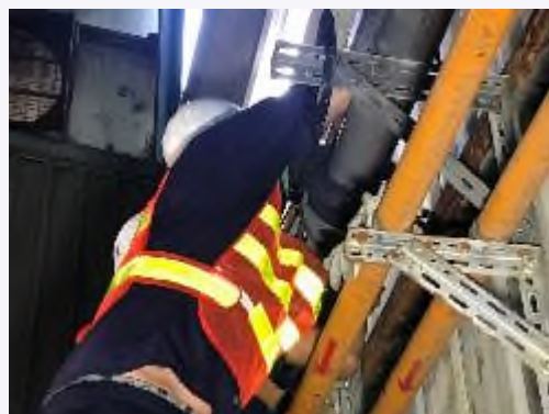
裝設即時感測設備
