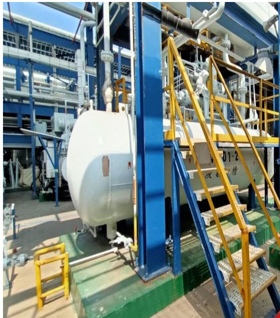
液氨儲槽架高(未與地面接觸)，可目視評估 是否有洩漏情形 (台化PABS廠案例)
