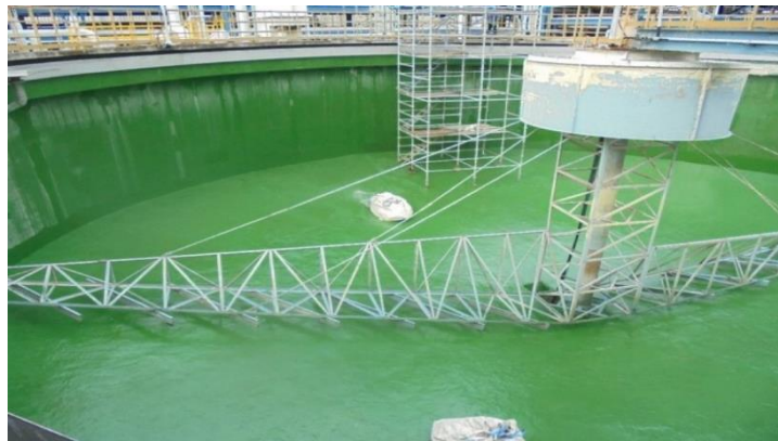
桶槽鋪設FRP 不滲漏材 (台化廢水場 案例)
