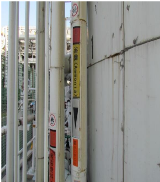
液氨由密閉管線輸送 (南亞MA廠案例)
