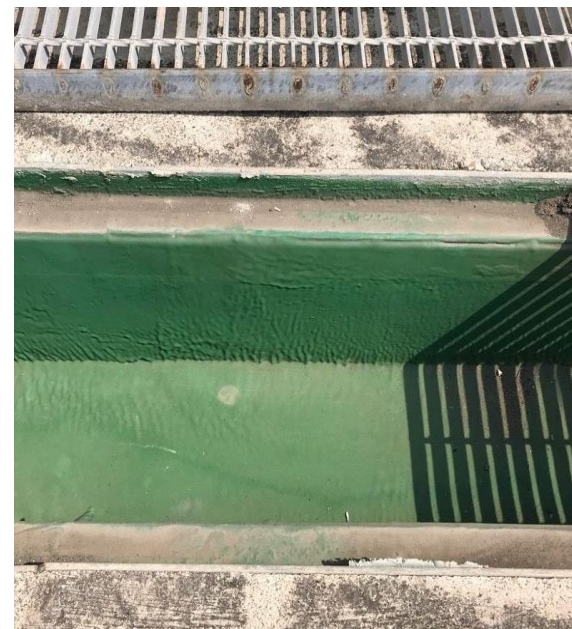
製程溝鋪設聚脲樹酯 (台塑正丁醇廠案例)
