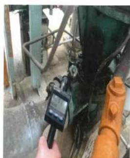
PUMP 改台，製程流體排空，Y 型濾網重新安裝加鎖，複測值 3.52ppm
