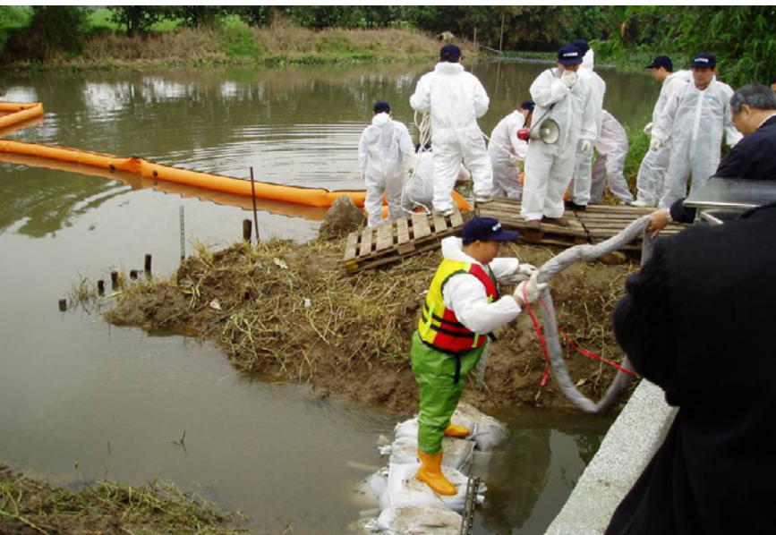
圖 2-4-7 93 年 3 月 30 日環保署假臺北市北投焚化爐舉辦「水污染事件緊急應變處理作業講習及器材實作示範」佈設河川型攔油索阻斷油污擴散
