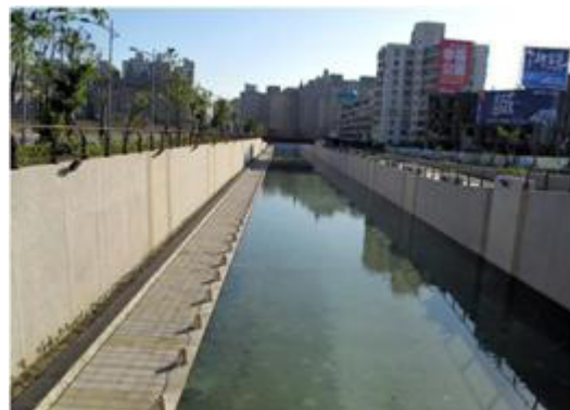
中港大排 - 整治後
