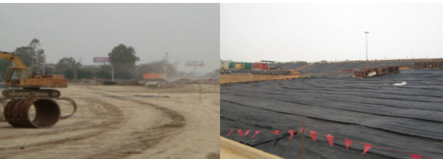
圖 2-2-25 營建工程污染改善前後照片
