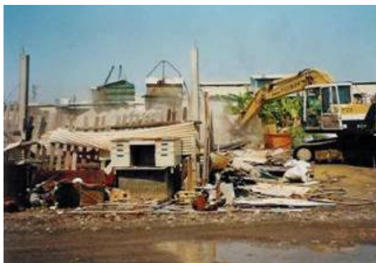
拆除二仁溪流域違法熔煉
