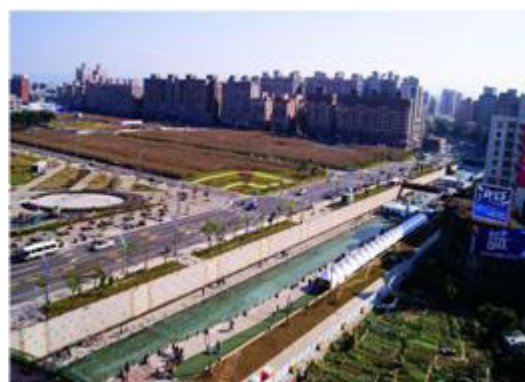
中港大排 - 整治後
