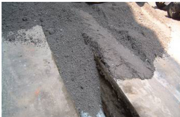
底渣再利用於管溝回填
