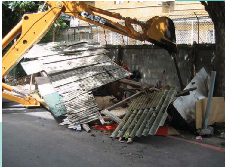
德行東路74巷15弄11違章拆除執行情形（中）
