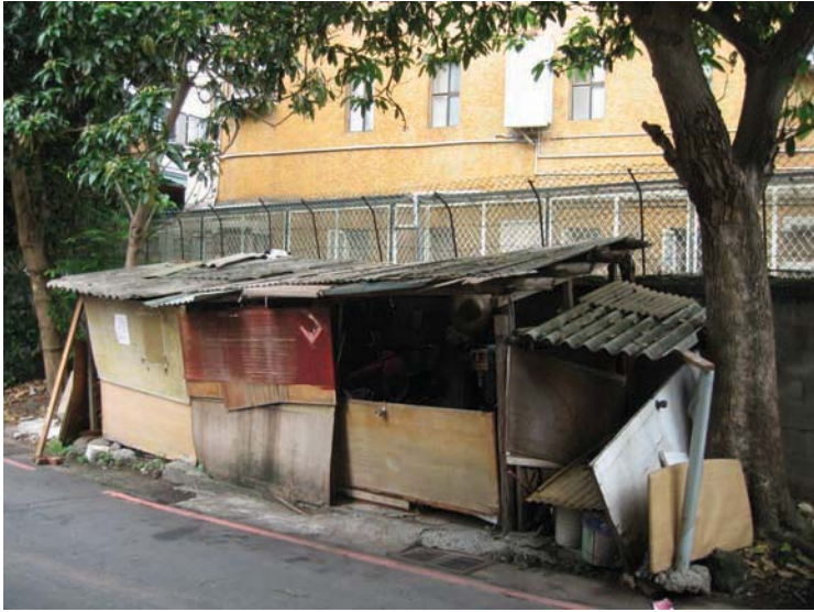
德行東路74巷15弄11違章拆除執行情形（前）
