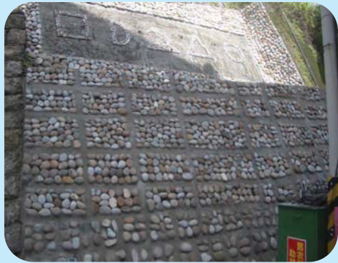
擋土牆剝落砌石整頓
