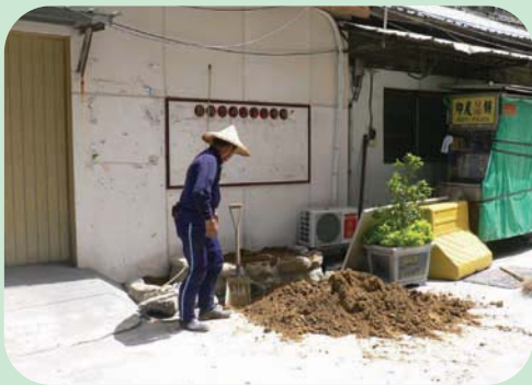
公布欄前綠美化施工中
