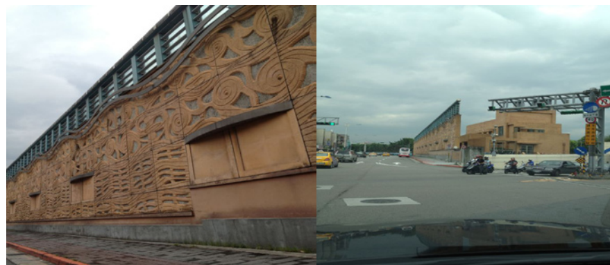
圖5.2-3 松山機場滑行道旁隔音牆
