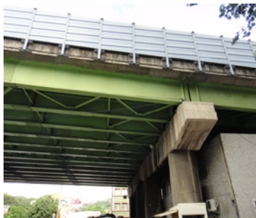
▲快速道路隔音牆
