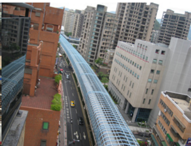
▲捷運全罩式隔音牆
