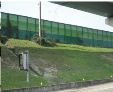
▲高速公路隔音牆
